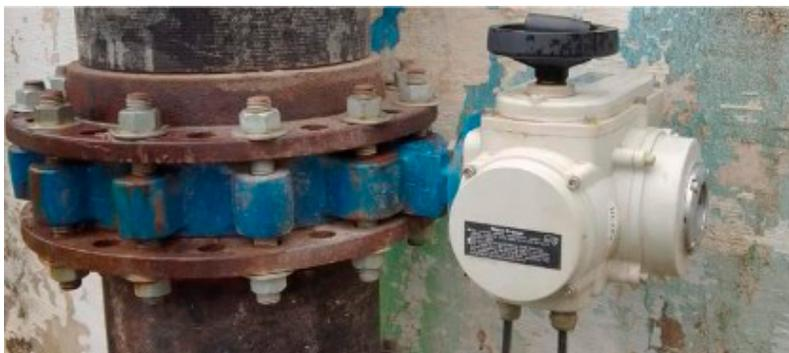
Figura 5.5: Válvula elétrica do tipo borboleta
