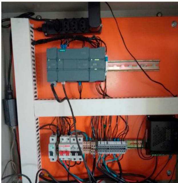
Figura 5.10: Controlador lógico programável do sistema de distribuição.
