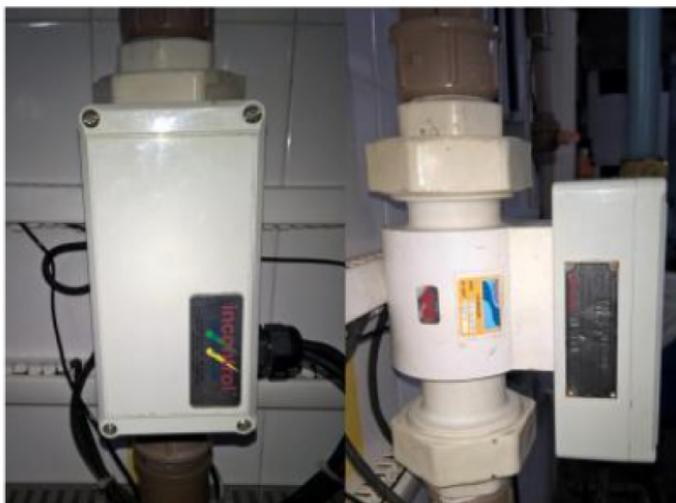
Figura 6.6: Transdutor de vazão utilizado. Fonte: (Flores, 2021).
