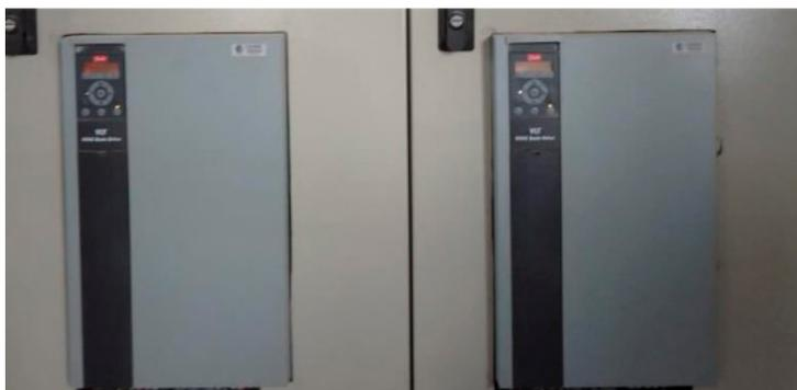
Figura 5.9: Inversores de frequência do sistema de distribuição.
