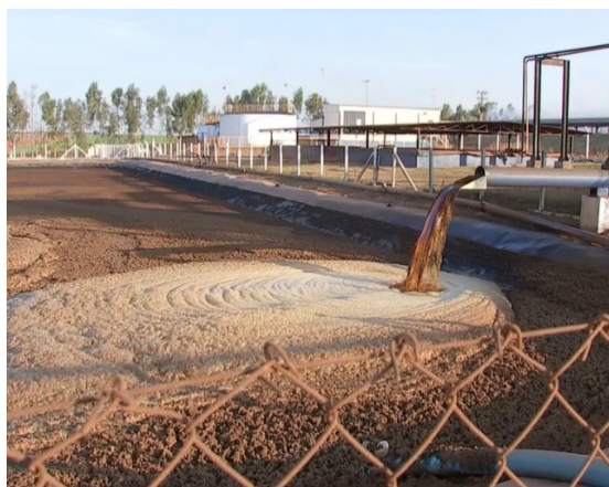
Figura 2 - Tanque reservatório de vinhaça
