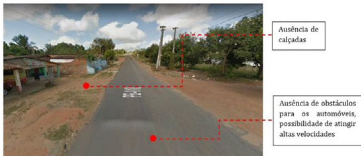
Figura 38 – PB-018 na área urbana do distrito Conde Sede. Fonte: Google Maps.
