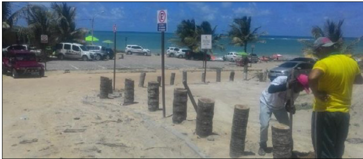
Figura 2 – Equipe na instalação das placas de Sinalização. Fonte: o Autor.
